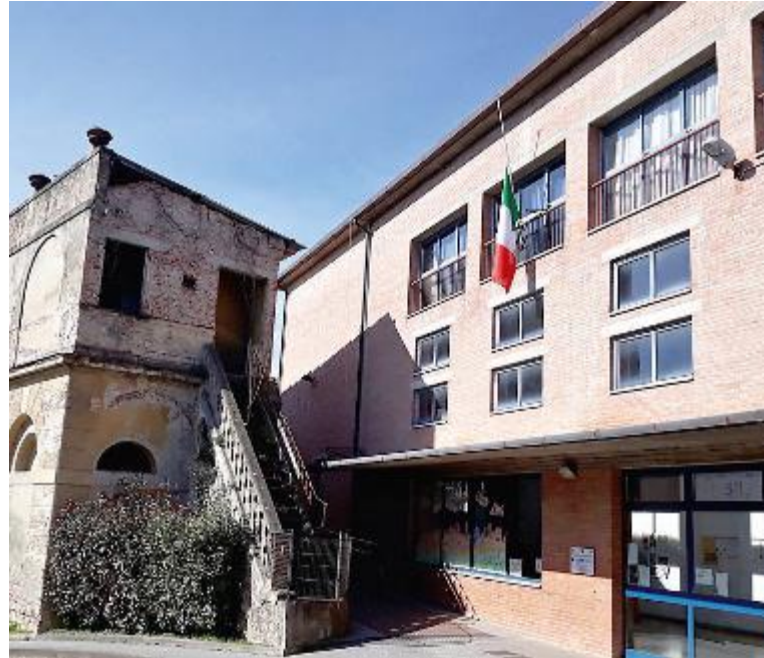
L'edificio sede della scuola Roncalli, realizzato tra il 1962 e il 1975
